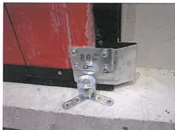
Roulette de guidage [26] et profilé de protection [31].
