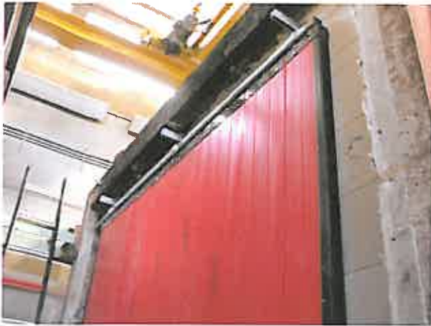
Raccrochement les panneaux.
