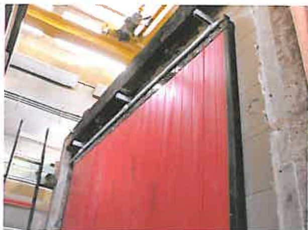
Raccrochement les panneaux.
