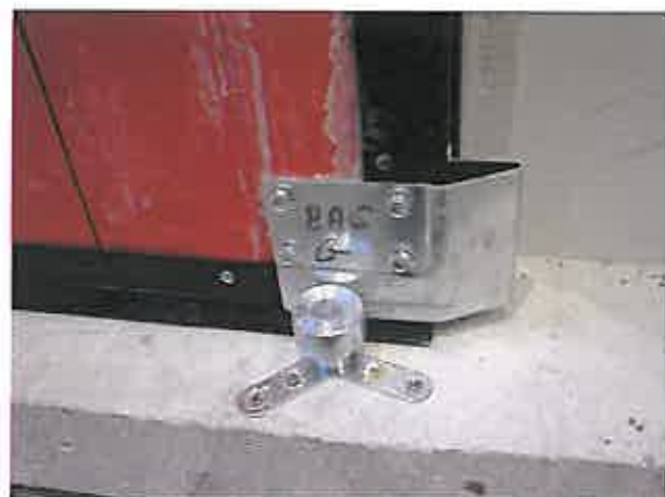
Roulette de guidage [26] et profilé de protection [31].
